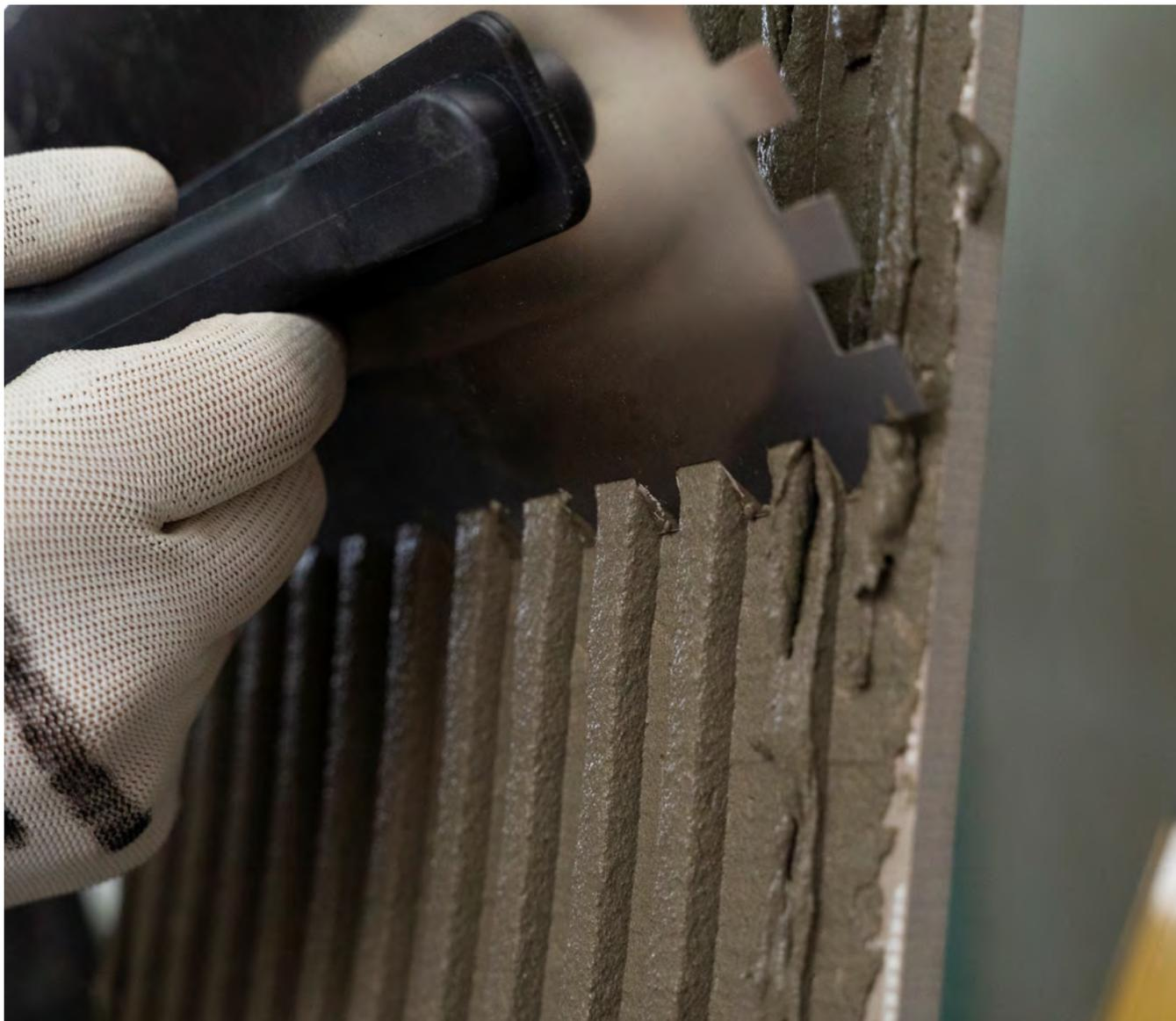
Для выравнивания неровностей основания до 20 мм и одновременной укладке облицовки.
