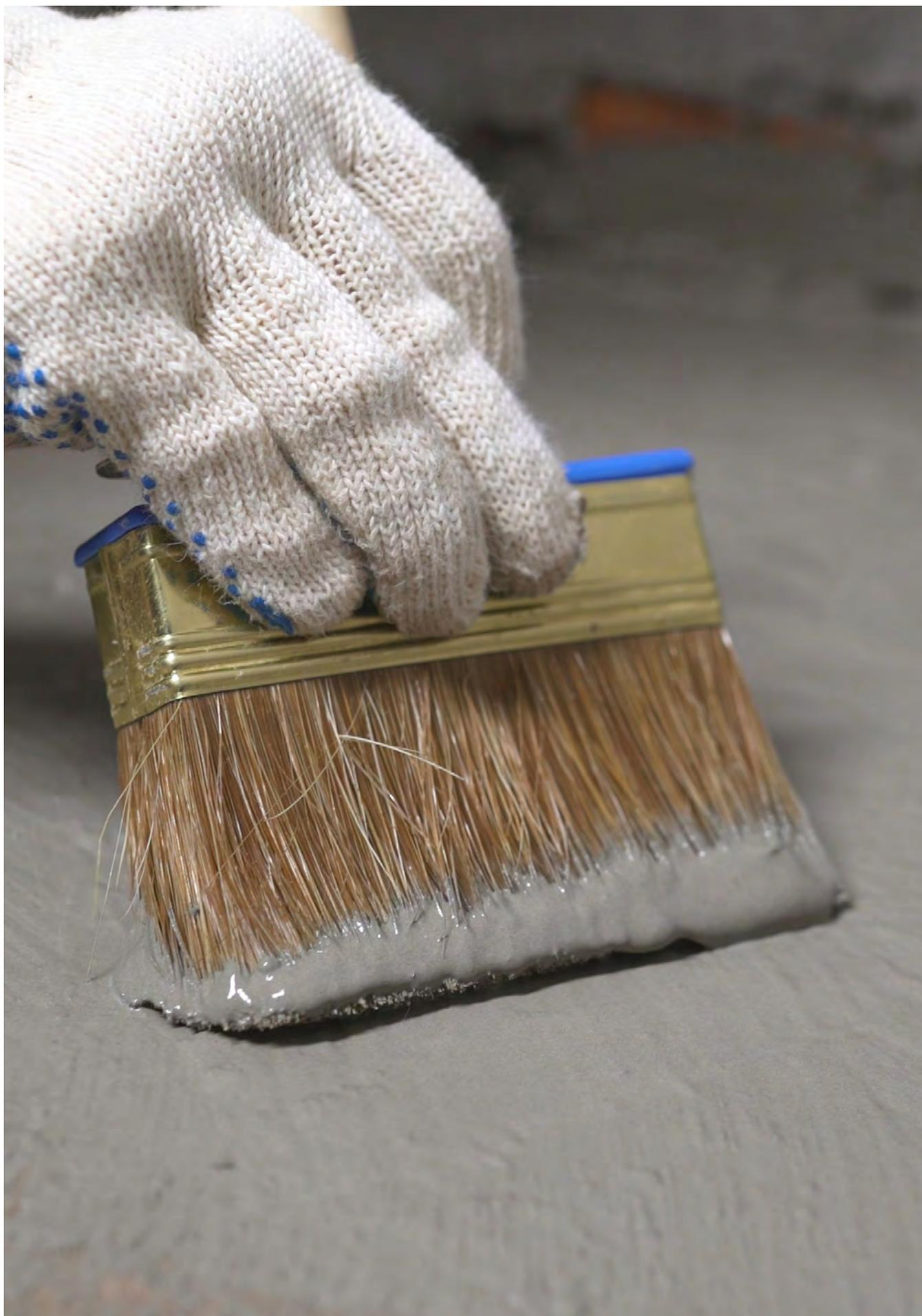
При вероятности капиллярного подсоса влаги из бетона
